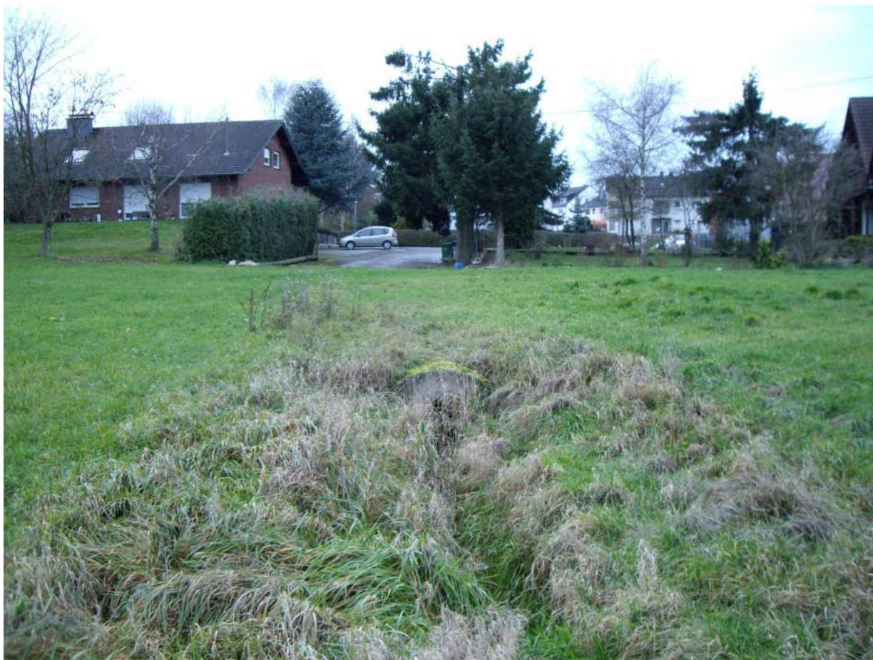
Abb.: Vorhandener, verrohrter Bereich des Heimbachs im Westen
