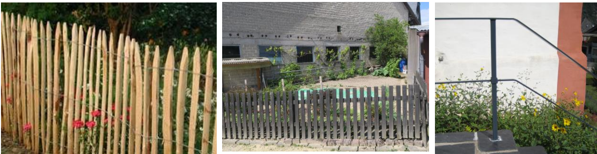
Wo Einfriedungen notwendig sind, bestehen diese aus einfachen Materialien und sind schlicht gestaltet.
