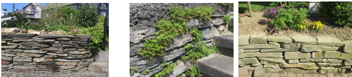
Oftmals finden sich Mauern, als Einfriedungen und/oder als Stützmauern in bewegter Topographie. Die Bruchsteinmauern bieten Lebensraum für viele an trockene (xerophile) Verhältnisse angepasste Tier- und Pflanzenarten. Viele der Pflanzenarten haben markante Blüten, so dass die Vegetation der Trockenmauern gestalterisch wirken kann.
