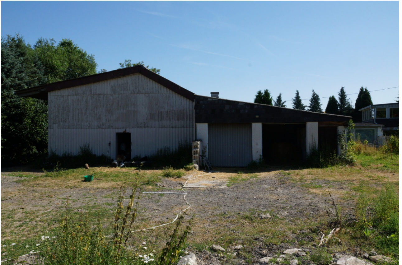
Foto 6: Blick aus Richtung Westen auf die Rückseite des Wirtschaftsgebäudes und die davor liegende Lager- und Stellfläche
