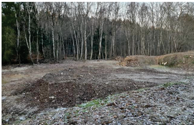
Foto 12: Birkenwald, im Vordergrund Bodensanierungsmaßnahme
