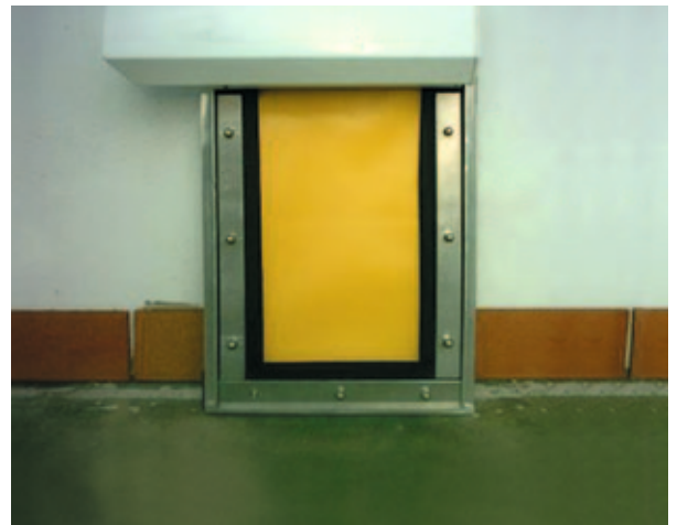
Folienabdichtung für Gebäudeöffnungen
