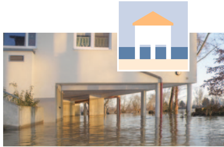
Ausweichen: zum Beispiel durch Aufständern von Gebäuden
