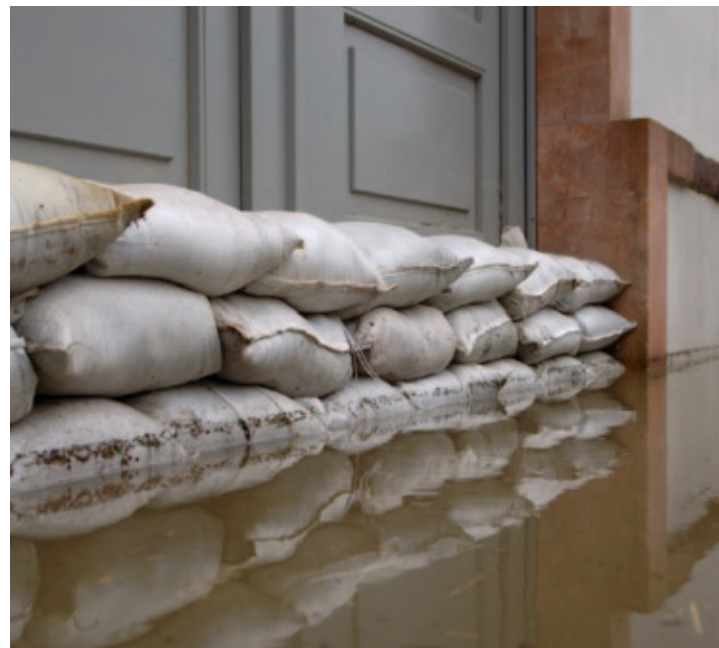
Notfallmäßiger Objektschutz mit Sandsäcken
