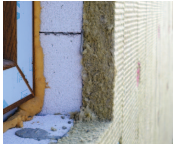
Einsatz von Mineralfaserplatten als Außenwanddämmung
