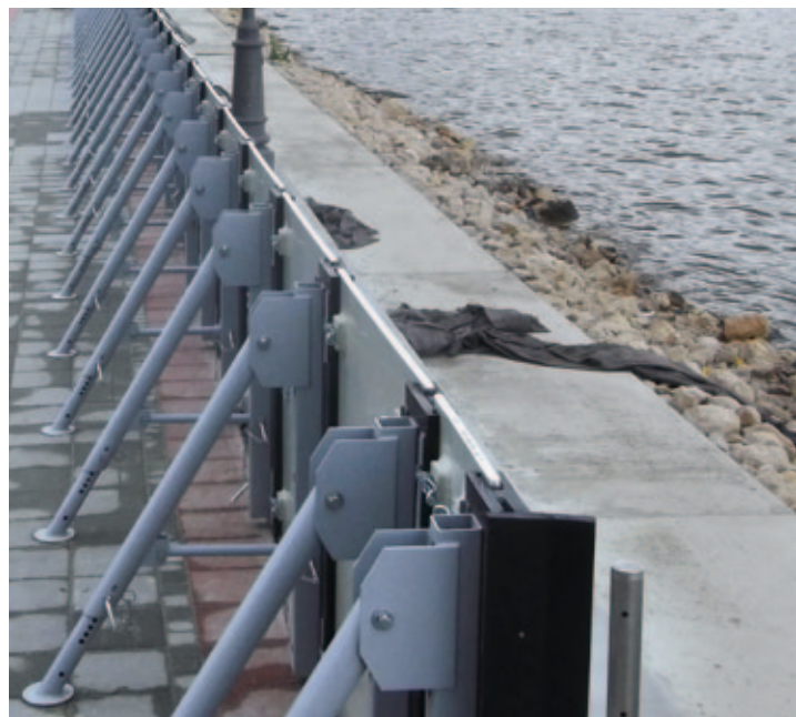
Hochwasserschutz mit Hochwasserschutzplatten aus Kunststoff
