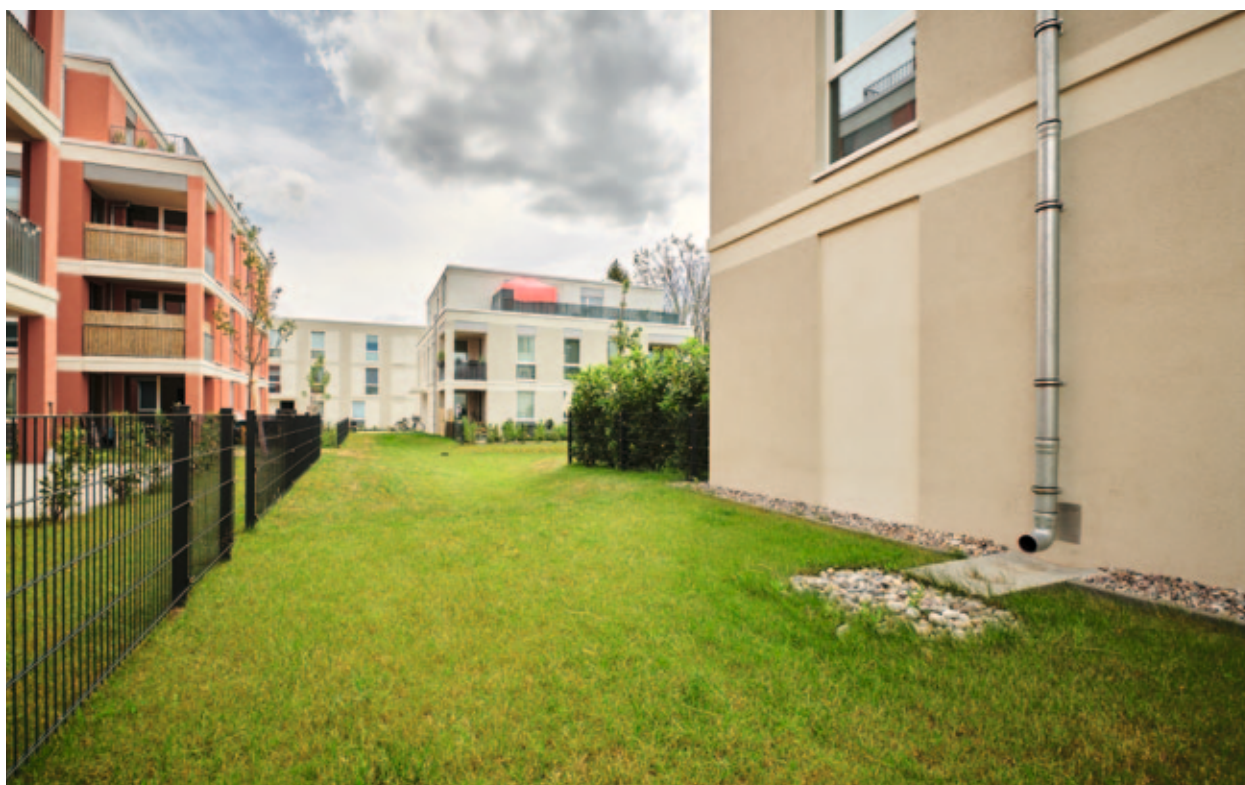
Dezentrale Rückhaltung von Niederschlagswasser
