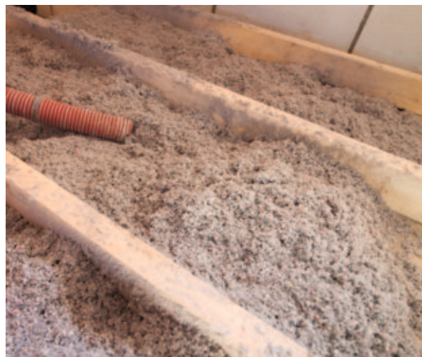
Anwendung von Zelluloseflocken im Fußbodenbereich
