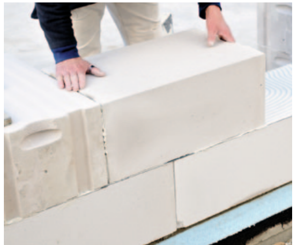
Mauerwerk aus Porenbeton-Plansteinen
