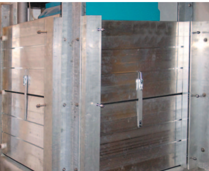
Sicherung einer Feuerstätte vor dem Wasserzutritt
