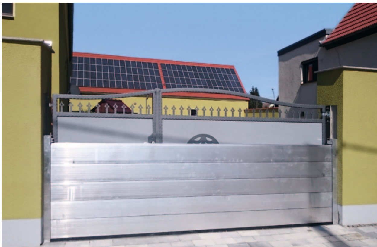
Mobiler Hochwasserschutz mit Dammbalken
