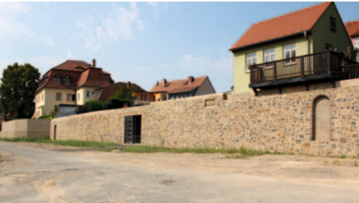
Integrierter Hochwasserschutz in der historischen Stadtmauer ...
