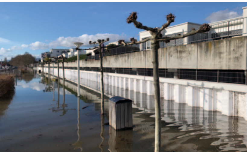
Hochwasserschutzwand mit eingemramter Stahlpundwand
