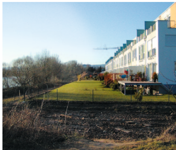
Hochwasserangepasste Bauweise mit erhöhtem Erdgeschoss
