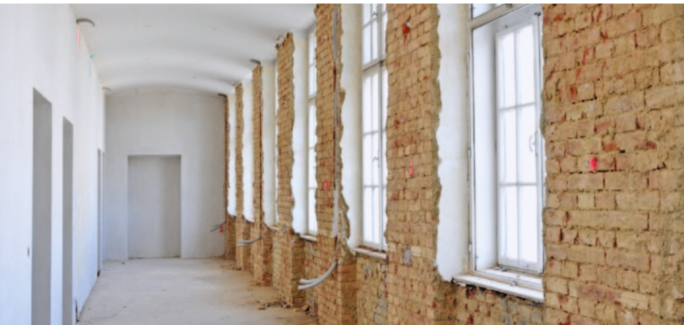
Entfernter Putz zur besseren Trocknung einer Außenwand
