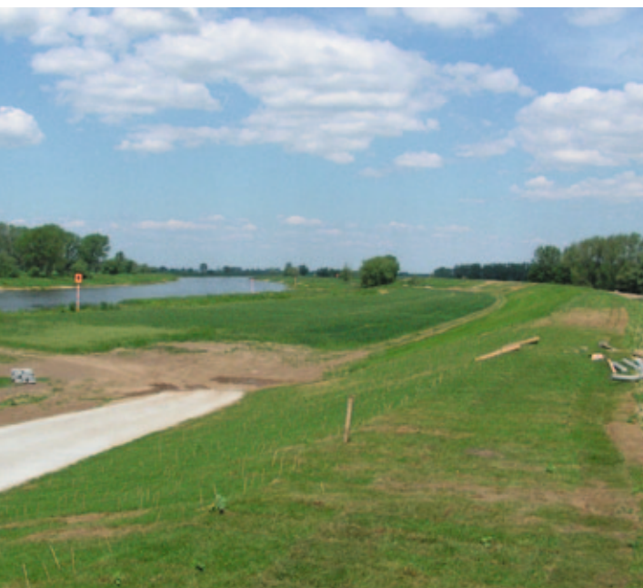
Sanierter Hochwasserschutzdeich an der Elbe
