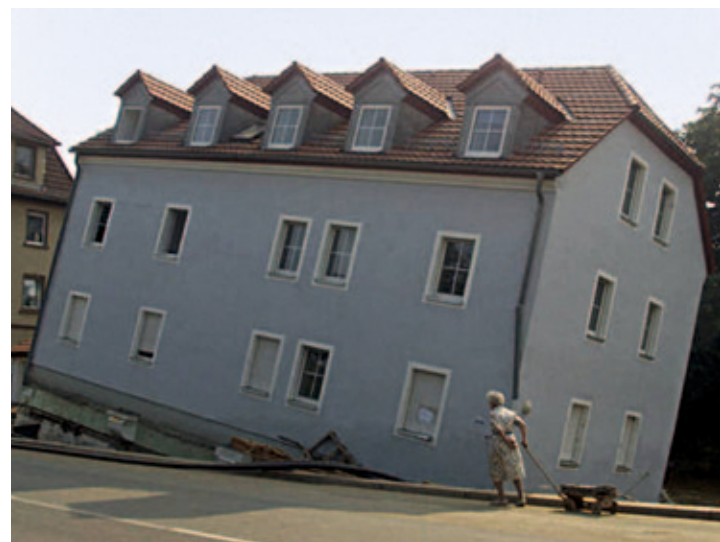
Unterspültes Haus an der Weißeritz
