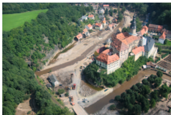
Hochwasserschäden 2002 in Weesenstein an der Müglitz ...
