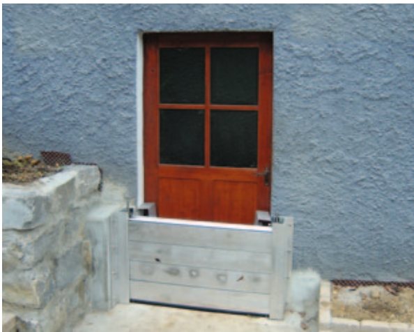
Objektschutz an Gebäudeöffnungen
