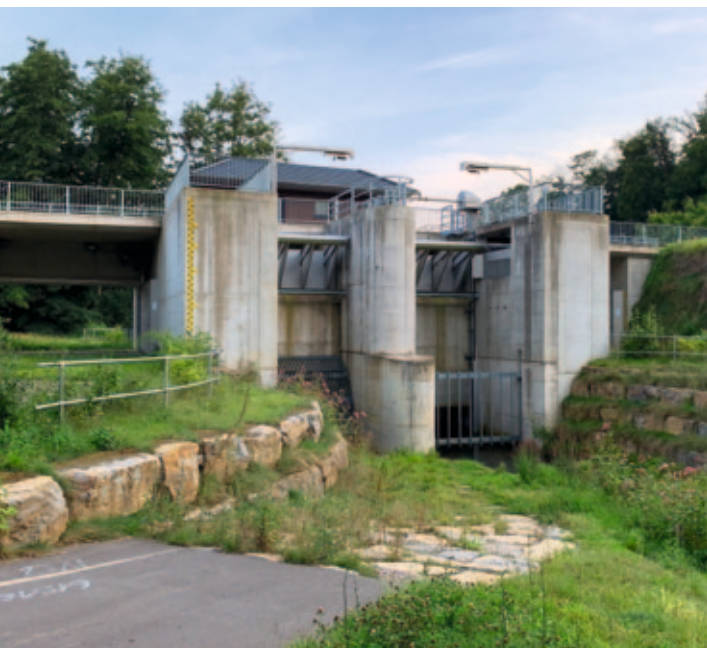
Verschlussbauwerk eines Hochwasserrückhaltebeckens
