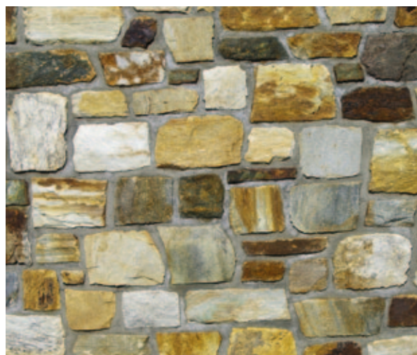
Unregelmäßiges Natursteinmauerwerk
