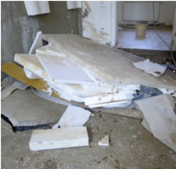
Aufgeschwommene Fußbodenkonstruktion
