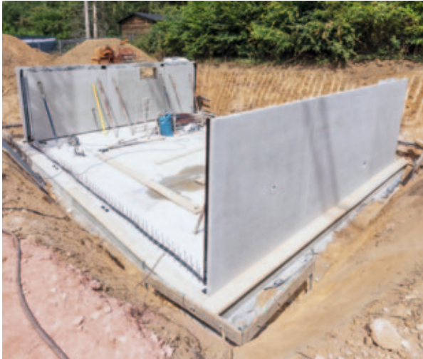
Keller in WU-Bauweise
