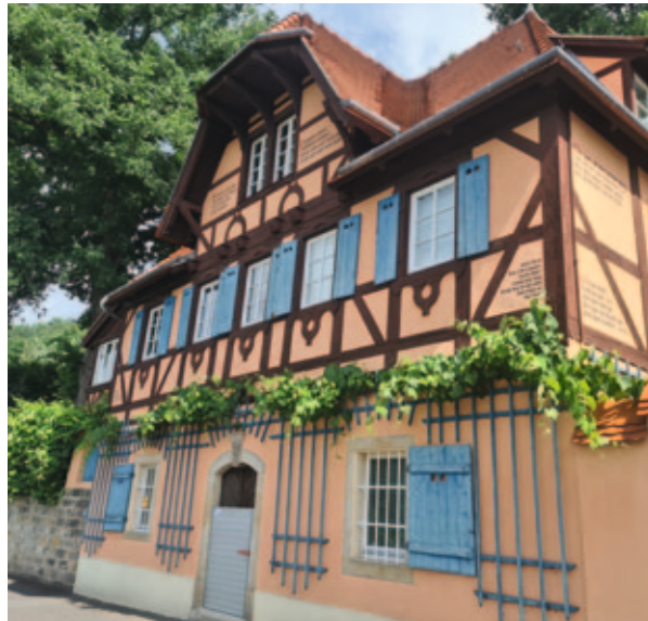
Denkmalschutz mit Hochwasserschutz
