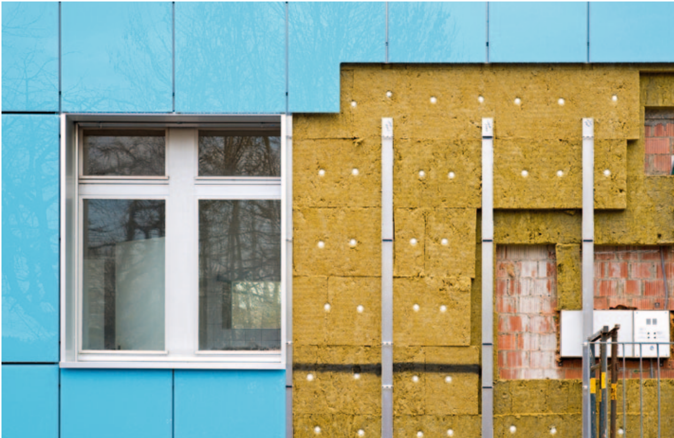
Hinterlüftete Fassadenkonstruktion
