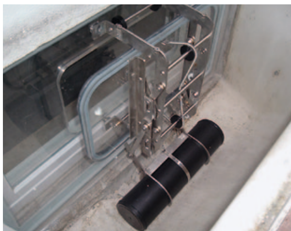
Automatisch schließende Vorsatzscheibe
